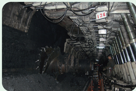
双鸭山矿业集团公司东荣三矿综采工作面
