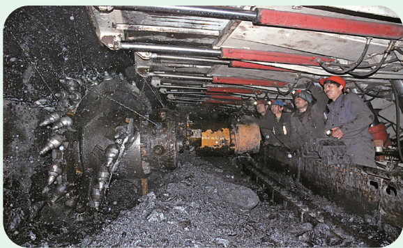
七台河矿业精煤（集团）公司桃山煤矿井下综采机组
