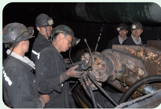
鹤岗矿业集团公司南山煤矿井下检修
