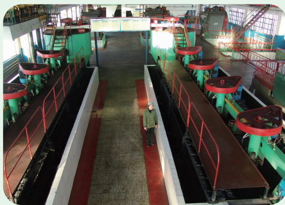
七台河矿务局新兴选煤厂选煤车间
