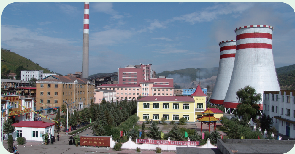
鸡西矿业（集团）有限责任公司矸石热电厂煤矸石综合利用发电
