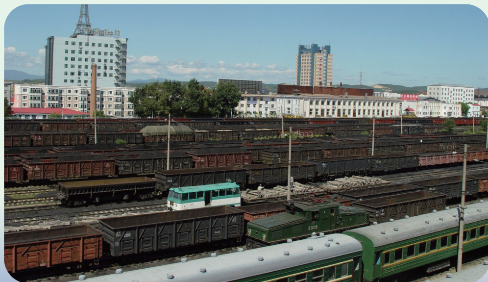
鹤岗矿业集团公司矿区铁路枢纽集配站场
