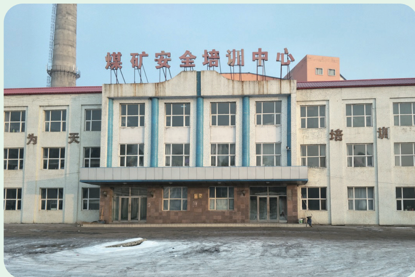
双鸭山市煤矿安全培训中心 教学楼
