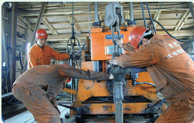
鹤岗大地勘探公司地质勘查钻孔施工
