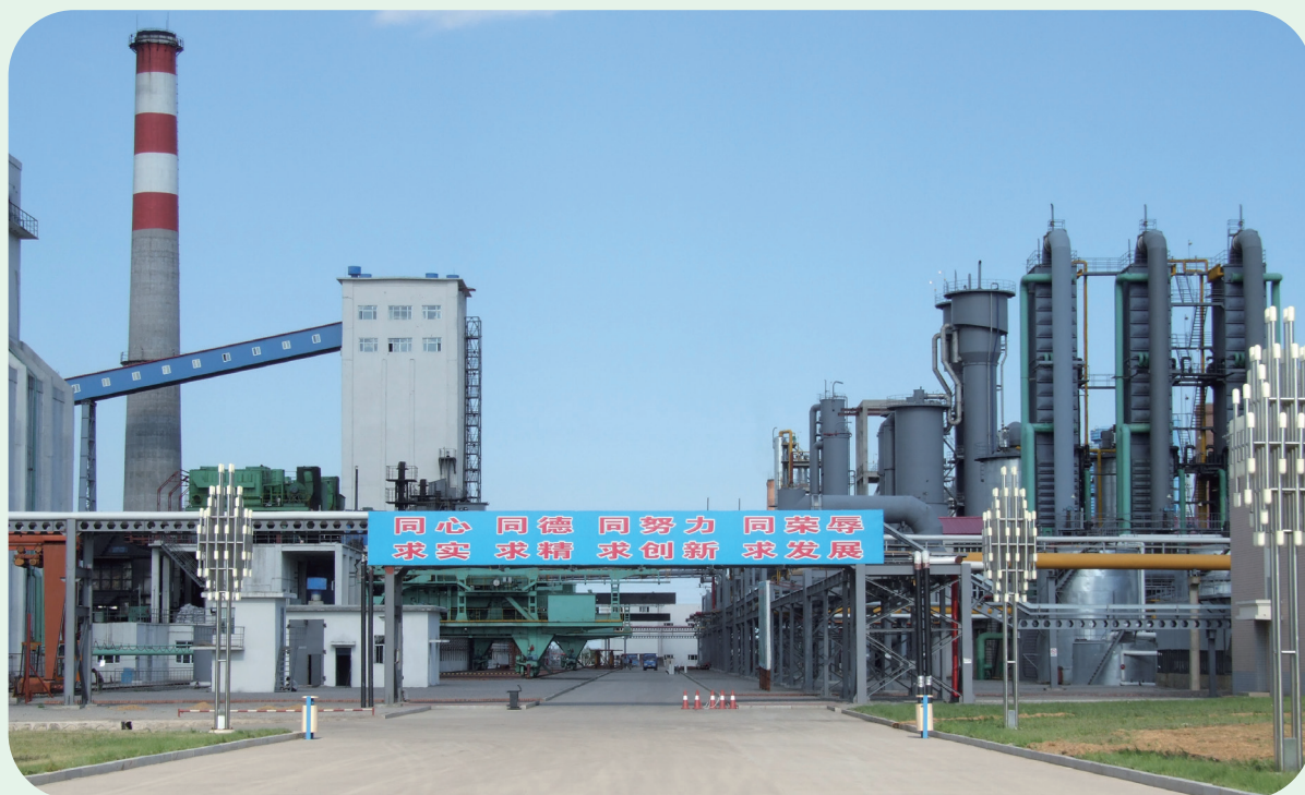
年设计生产能力 96 万吨的二级优质冶金焦炭、装机容量 3.1 万千瓦燃气发电厂的七台河龙洋焦电公司（摄于 2004 年 2 月 6 日）
