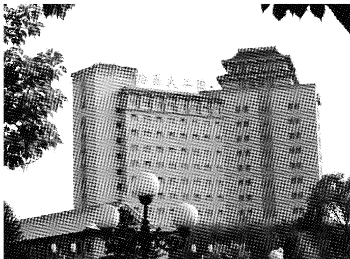
哈尔滨医科大学附属第二医院外科大楼
